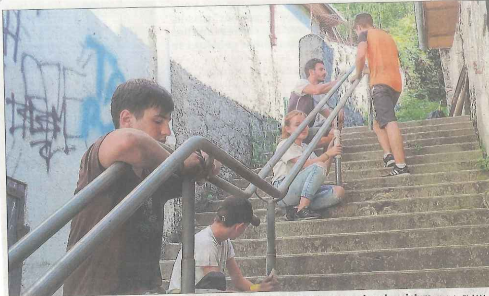
Hier matin, une équipe effectuait les préparatifs avant la pose de plusieurs couches de peinture. Photo Le DL/M.M.
